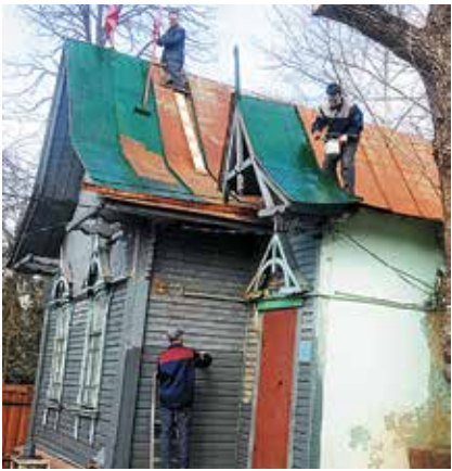
Работники ВЧДр Арзамас приводят в порядок здание штаба Поста № 1
